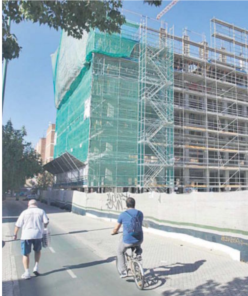
Dos transeúntes pasan delante de la obra de una gran promoción de viviendas en Sevilla capital.
