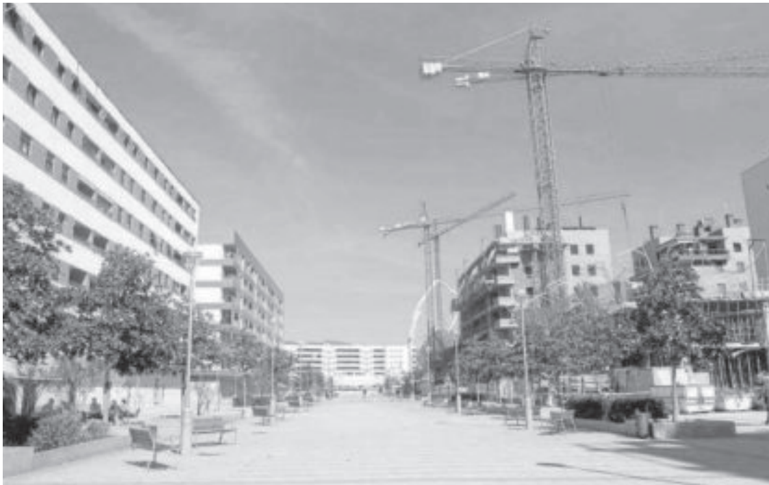
Urbanizaciones en construcción en el Nuevo Zoco.
