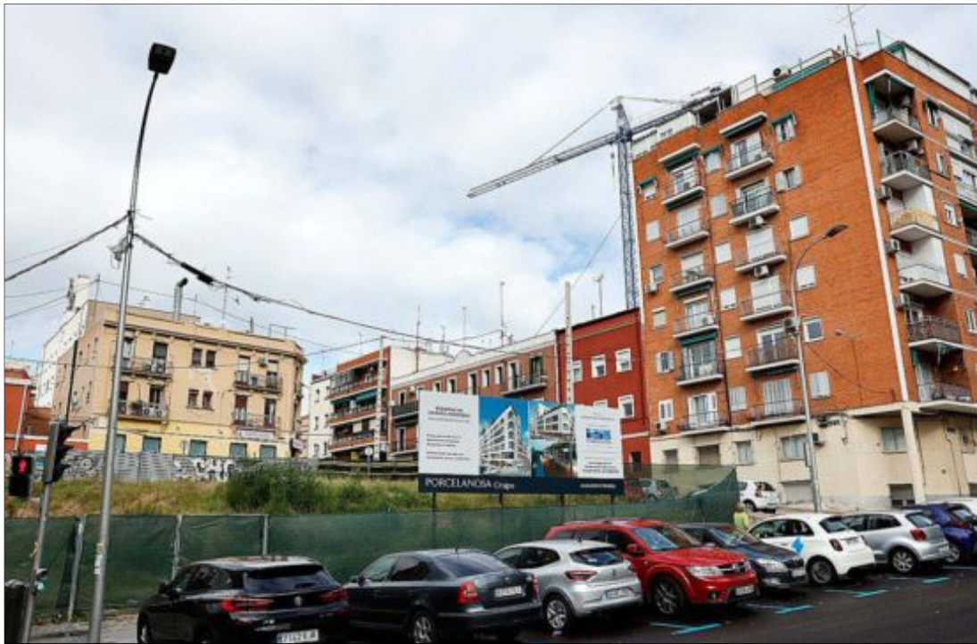
La promoción de viviendas Residencial Infanta Mercedes, ubicada en el barrio de Castillejos, en el distrito de Tetuán. BERNARDO DÍAZ
