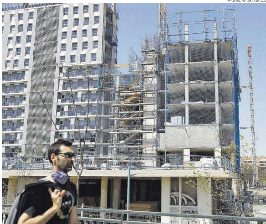
Un edificio de viviendas de obra nueva que se está en construcción junto a la plaza Europa de Zaragoza.
