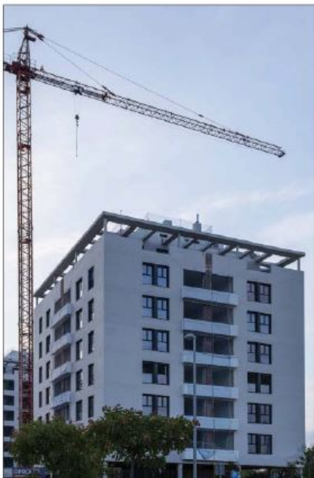
Edificio de viviendas en construcción. DAN G. MARTA
